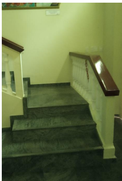
Figura 16- ESCADA COM PATAMAR EXISTENTE
