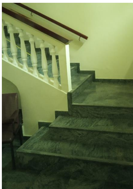
Figura 18- LOCAL DA INSTALAÇÃO DO GUARDA CORPO METÁLICO
