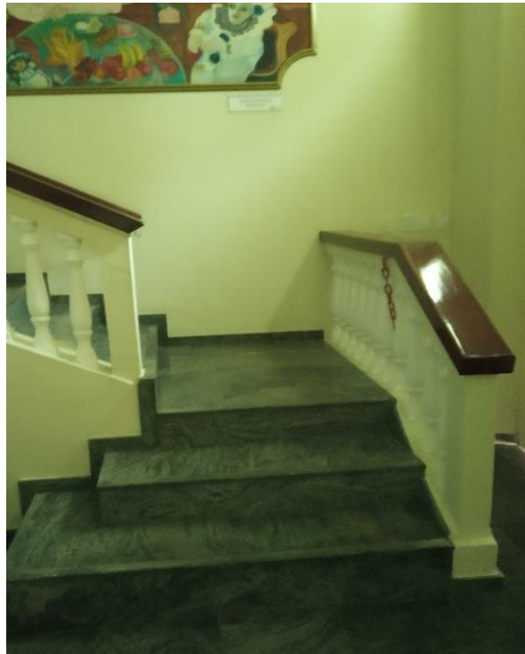
Figura 9 - ESCADA E PATAMAR EXISTENTE
